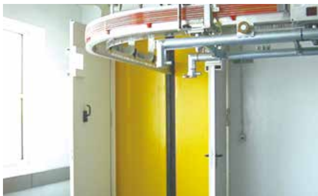
クレーンレール部分の切欠き 窓なし
