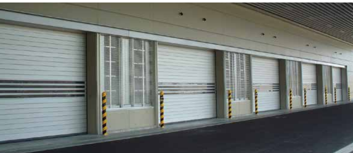
飲料品工場の出荷口への設置例
