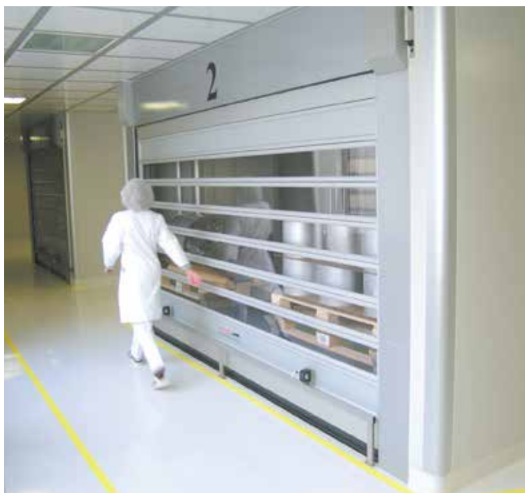
HACCP対応として、クリーンルーム内に設置された特殊仕様の超高速ターボドア。
