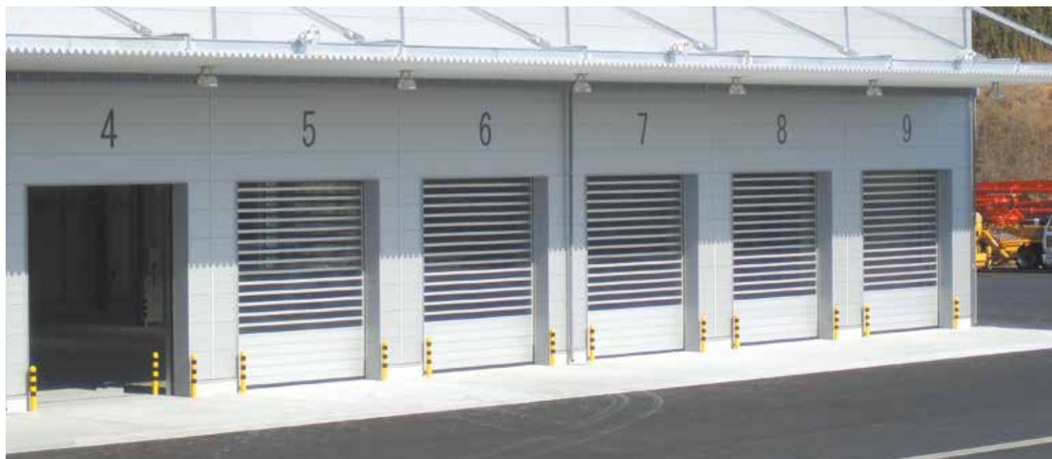
工場の出荷場への設置例
