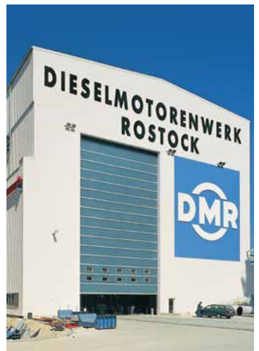
最大開口高さ25mの実績
