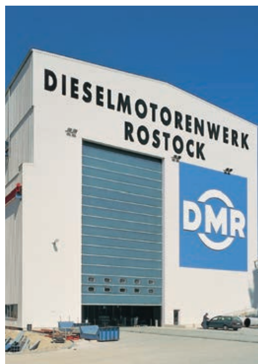
最大開口高さ25mの実績
