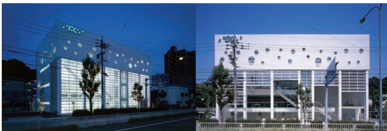
オフィスビルの壁面への納入実績 《設計:坂茂建築設計》
