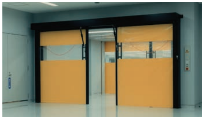
クリーンルームでの採用実績:エアーシャワー連動、インターロックシステム。 ※上記は旧型の写真です
