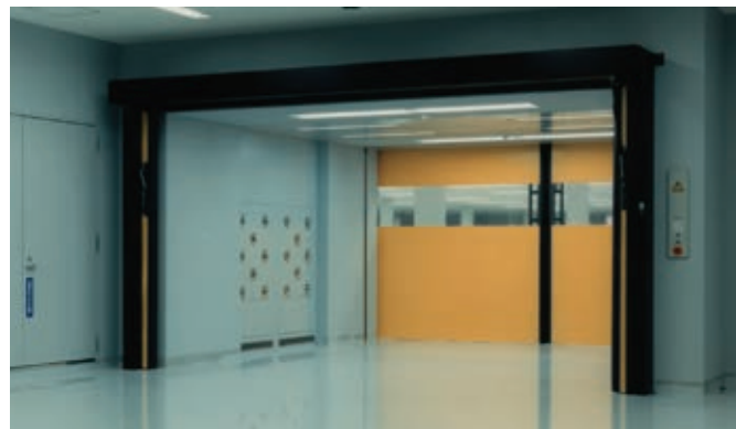
クリーンルームでの採用実績:エアーシャワー連動、インターロックシステム。 ※上記は旧型の写真です
